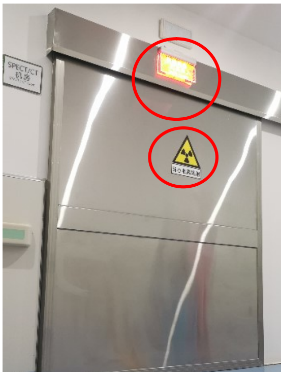
(a) SPECT/CT 机房工作状态指示灯及电离辐射警告标志
